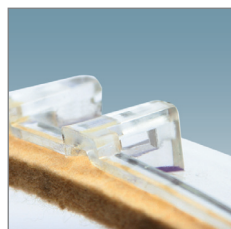
Уплотнительная прокладка по контуру из войлока
