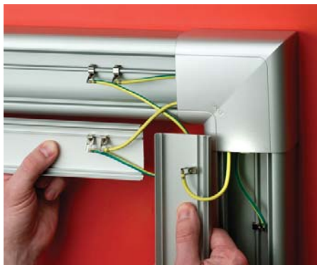
Количество монтируемых проводов заземления в плоском угле
